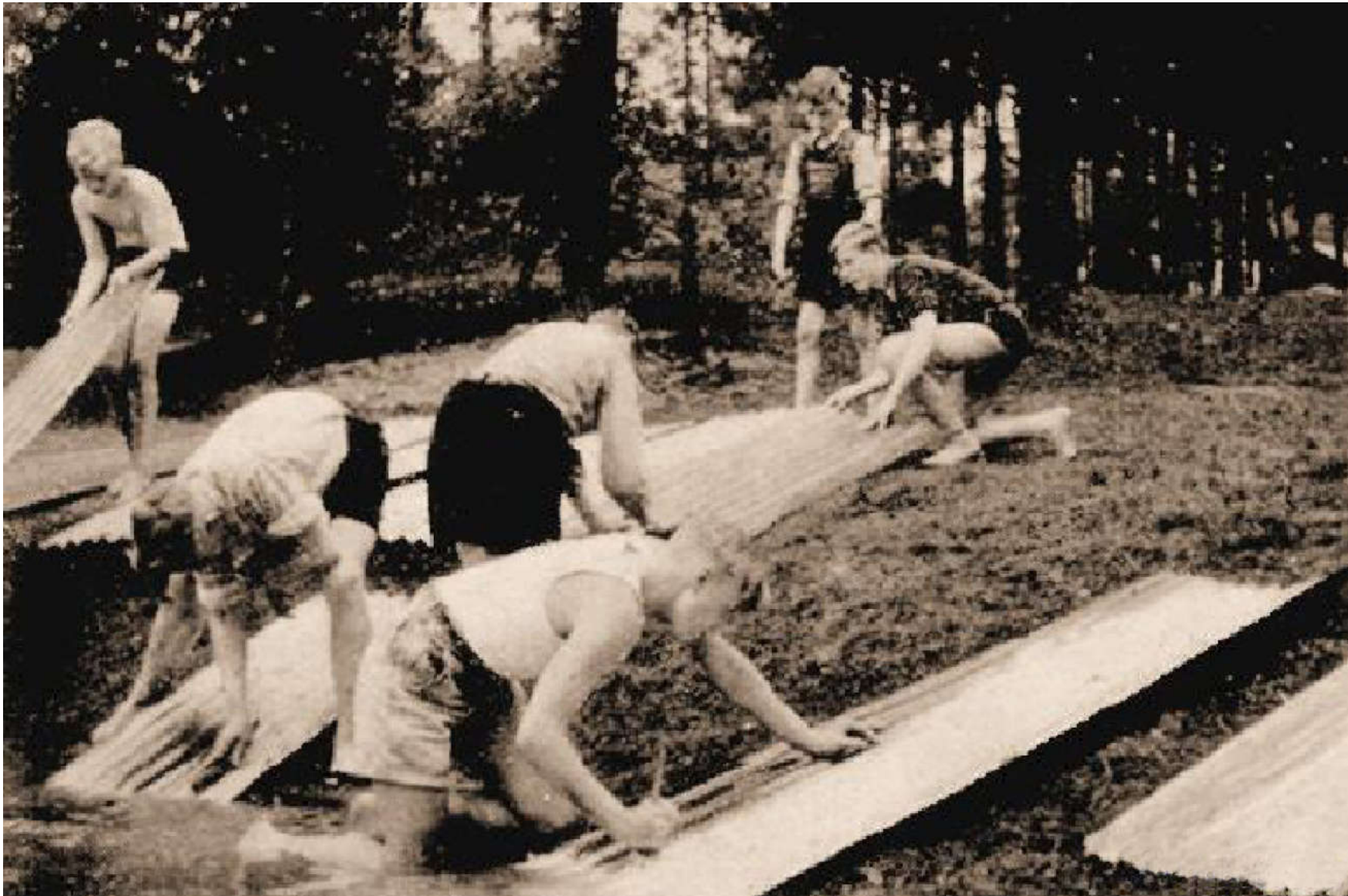
Die Hütten und das gesamte Baumaterial musste nach Bissel geschafft werden
