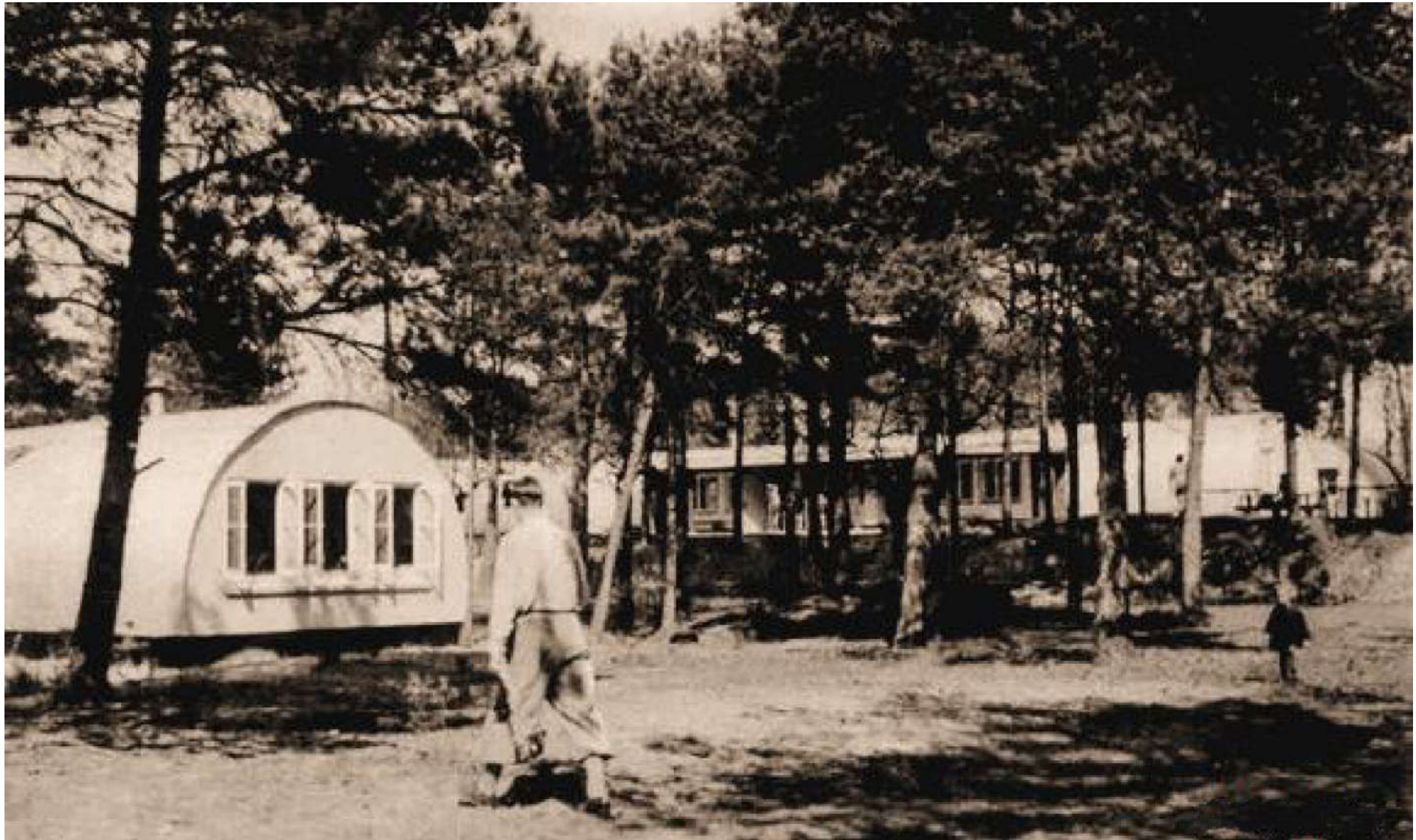
Die Hütten und das gesamte Baumaterial musste nach Bissel geschafft werden (1954)
